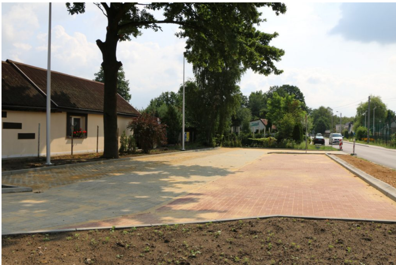
Pod koniec sierpnia zakończono budowę miejsc postojowych
