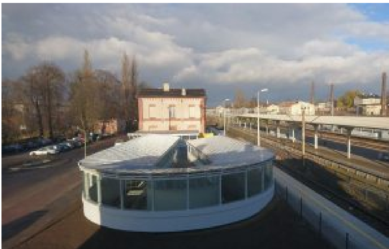
Widok z góry na zadaszoną pochylnię tunelu pieszorowerowego w
