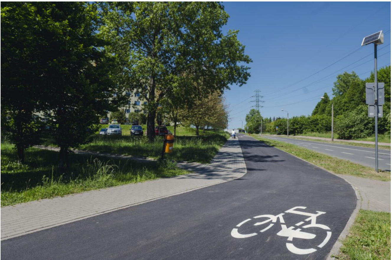
Ścieżka rowerowa po remoncie przy ul. Jagiełły
