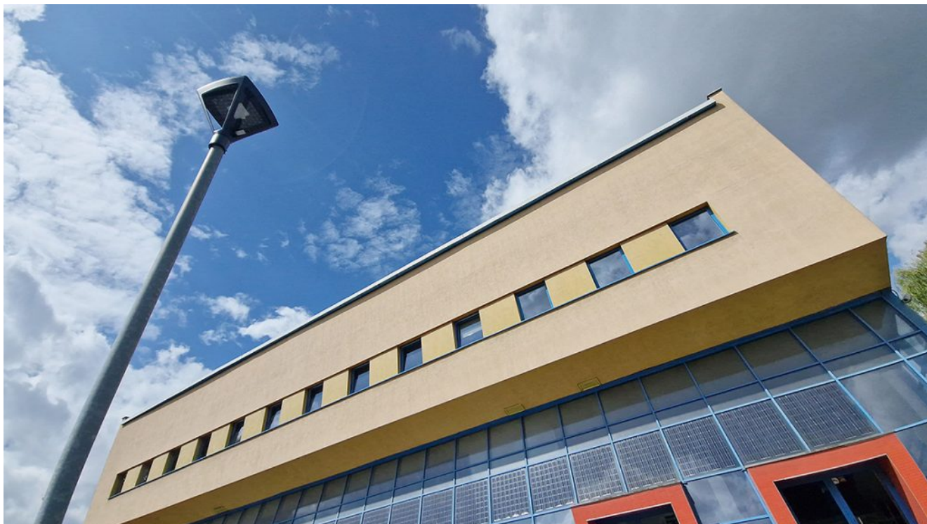
Ledowe oświetlenie przy Kompleksie Sportowym „Michał”.
