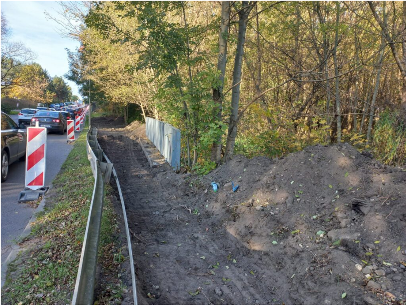
Budowa nowego chodnika przy ul. Zwycięstwa
