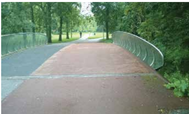
Zdjęcie 63 Kładka z barierą łukową. Amsterdam, Holandia
