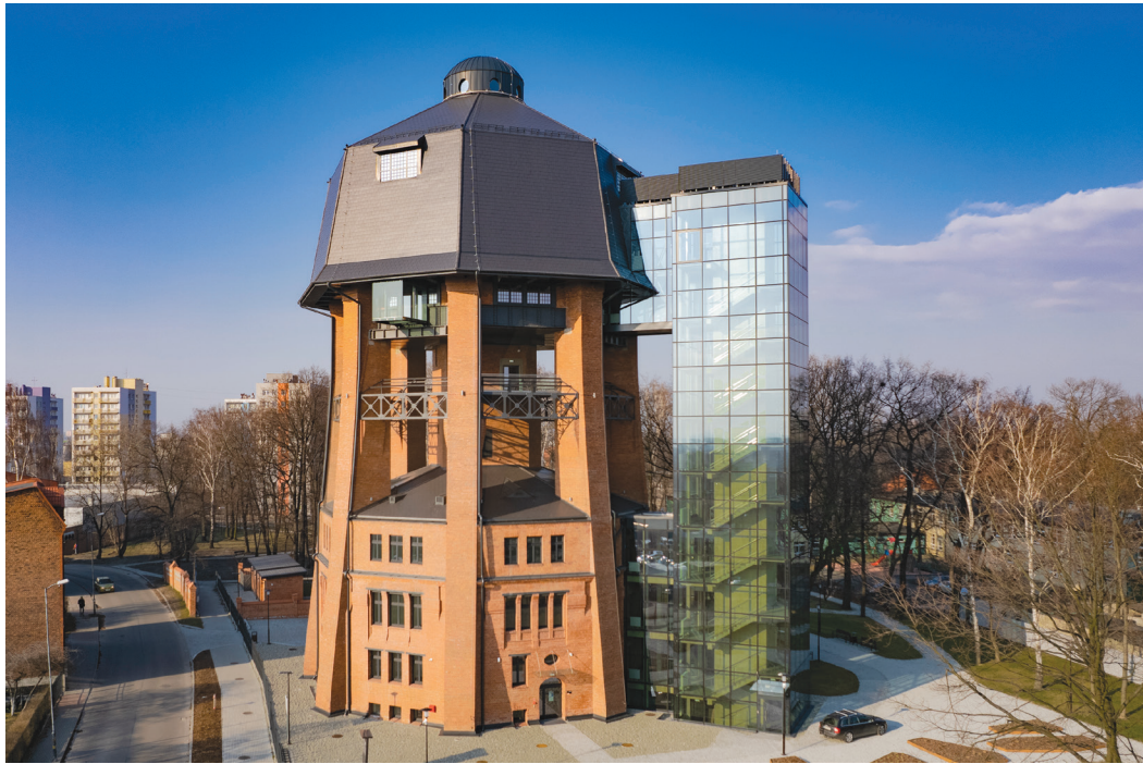
Wieża ciśnień w Zabrzu
