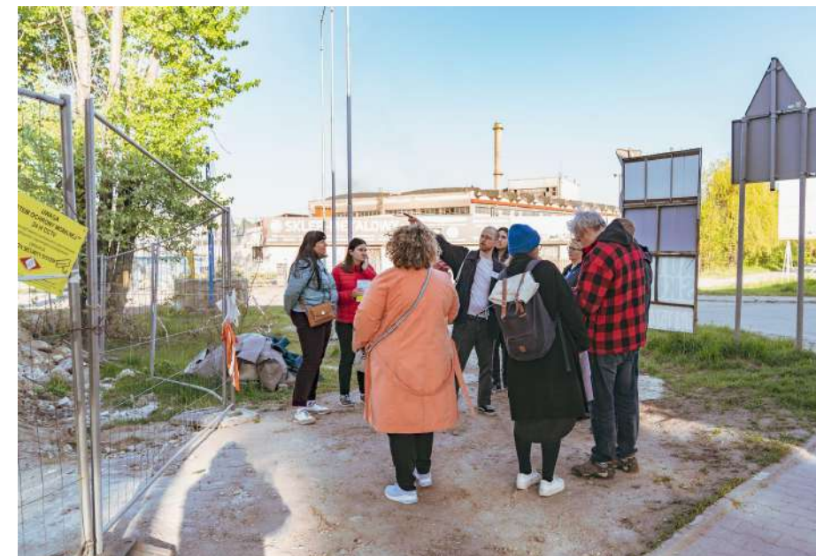
Na zdjęciu widać miejsce, gdzie powstają wejścia na perony.
