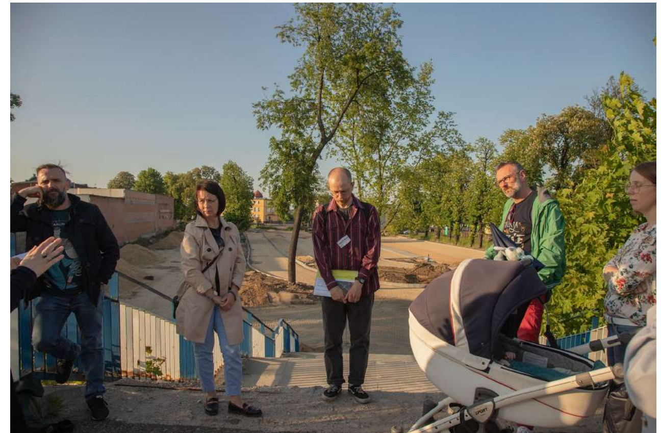
Na zdjęciu widoczne jest miejsce, gdzie powstaje przydworcowy parking.
