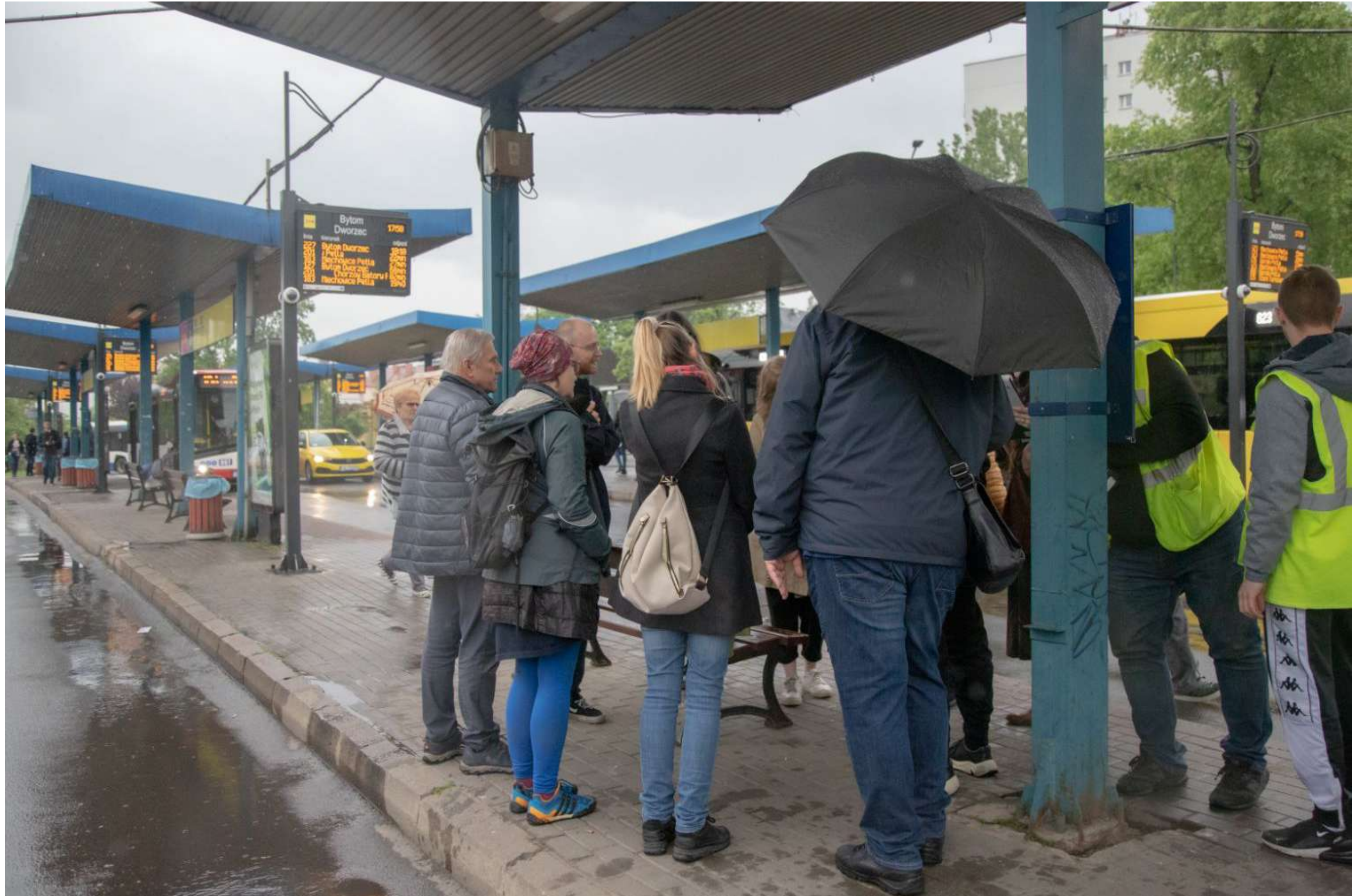
Perony dworca autobusowego są bardzo wąskie. Problemem jest też zadaszenie nieobejmujące całej długości przystanków.
