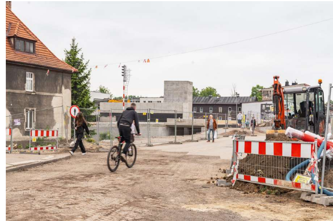
Widok na budowaną stację i wejście do tunelu pieszego.
