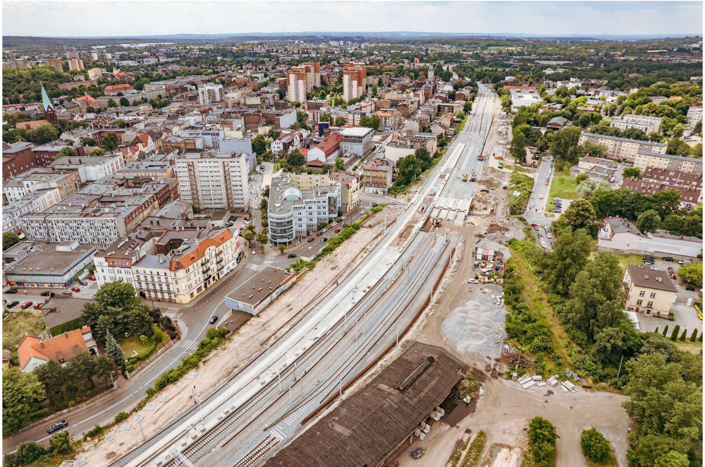
Widok na stację Chorzów Miasto. fot. Krzysztof Malinowski (2023 r.)
