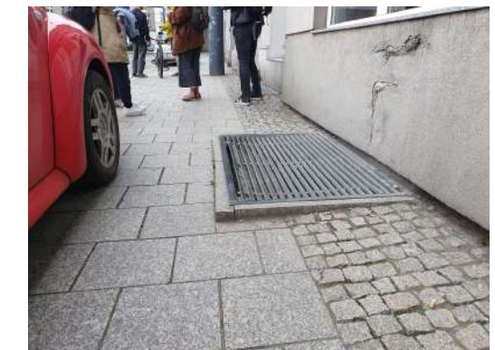
Na chodniku są przeszkody, które utrudniają chodzenie.
